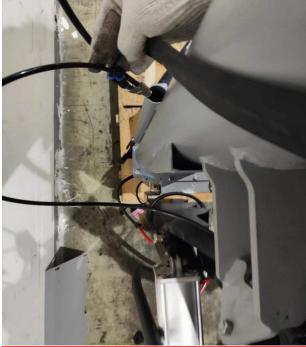
31.ONNECT THE BLACK AIR HOSE FROM THE ASSIST ARM TO THE T FITTING
